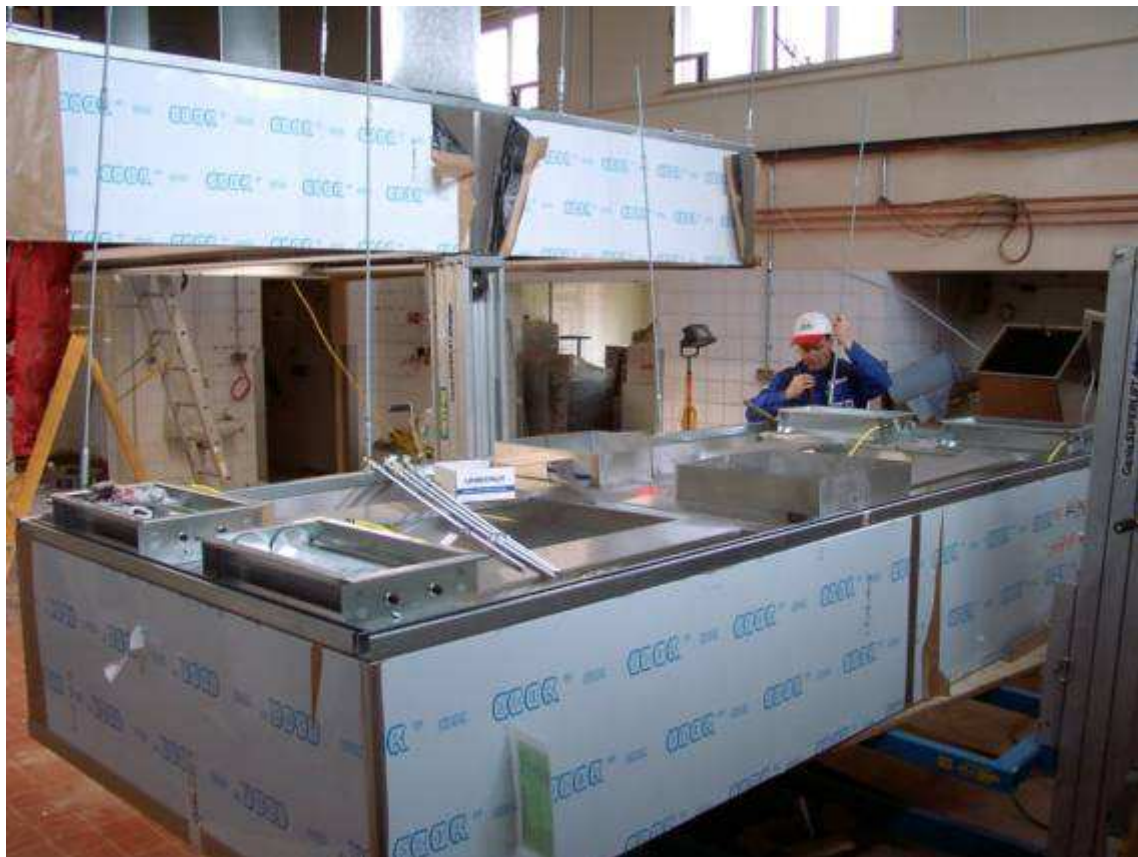
Montage einer Großküchenhaube. Der Wärmerückgewinner ist bauseitig ins Luftleitungsnetz integriert. (Abb. Reven)
