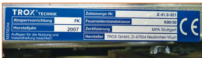
Abb. 2: Typenschild einer Brandschutzklappe mit Zulassungsnummer
