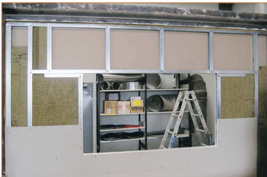
Abb. 4: Ständerprofilauswechslung der Unterkonstruktion (hier Aufbau für eine Brandprüfung nach DIN EN 1366-2)
