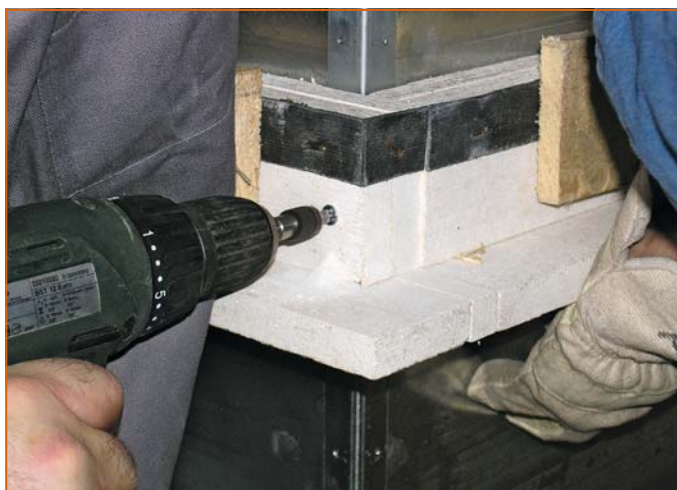
Abb. 3: Montage eines Einbaurahmens außerhalb der Wand
